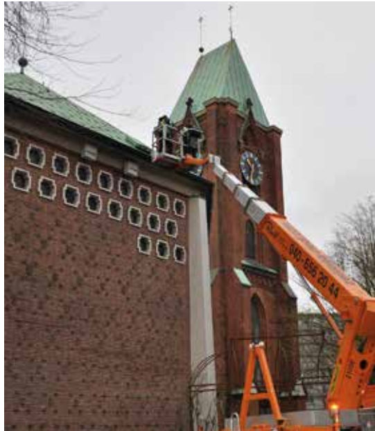
Erste Inspektion des Daches von oben und durch Einsteigen in eine Luke direkt über dem rechten Mauersegler-Kasten.
